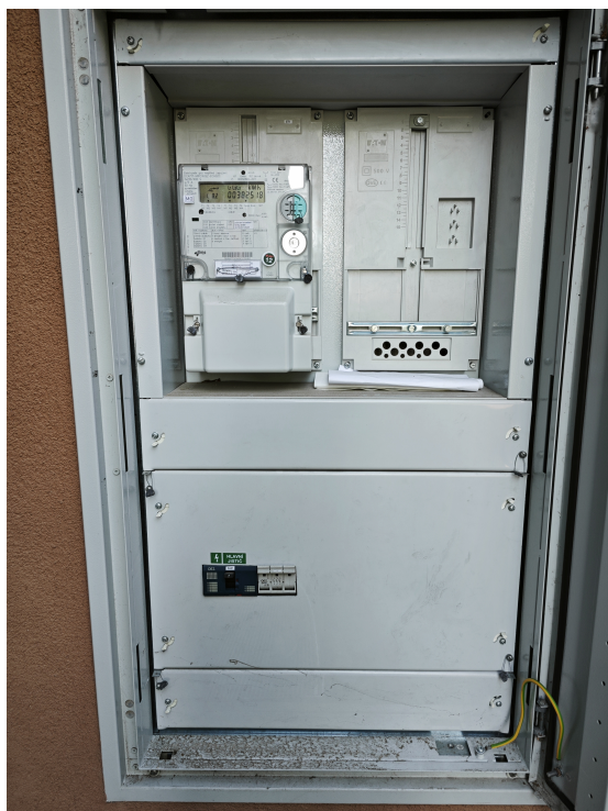
Obr. 6 – elektroměrný rozvaděč na severní fasádě objektu MŠ
